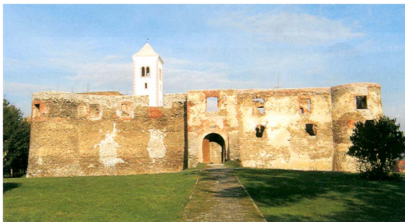
Ulazno pročelje utvrde u Kaptolu
